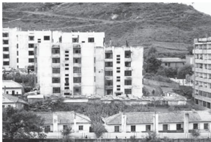
Conjuntos de apartamentos em Chongjin.
