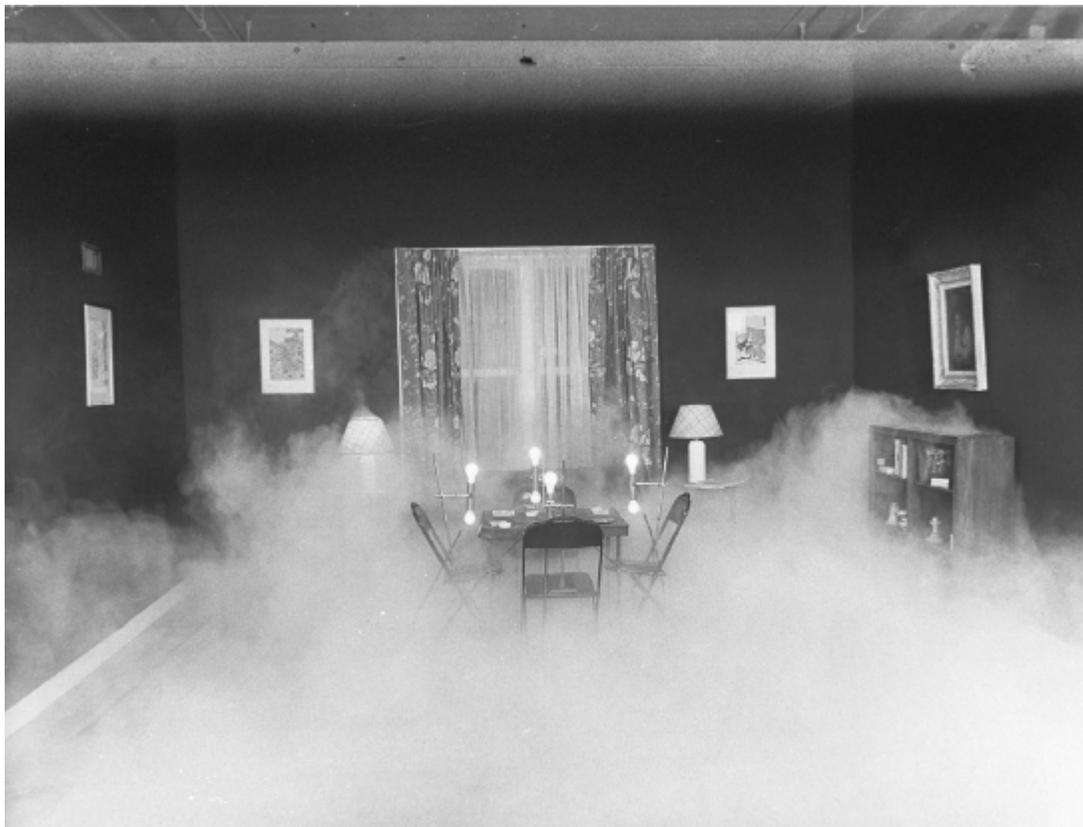
Laboratório experimental da Carrier Corporation testa seu novo aparelho de ar-condicionado central de US\$ 700, com capacidade para seis cômodos, que difunde o ar até o nível do chão; a névoa produzida na sala, chegando à altura de três metros, torna visível o ar mais frio, 1945.
