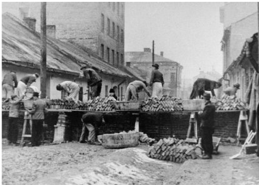
Judeus em Cracóvia obrigados a construir o muro em volta de seu gueto (1941)
