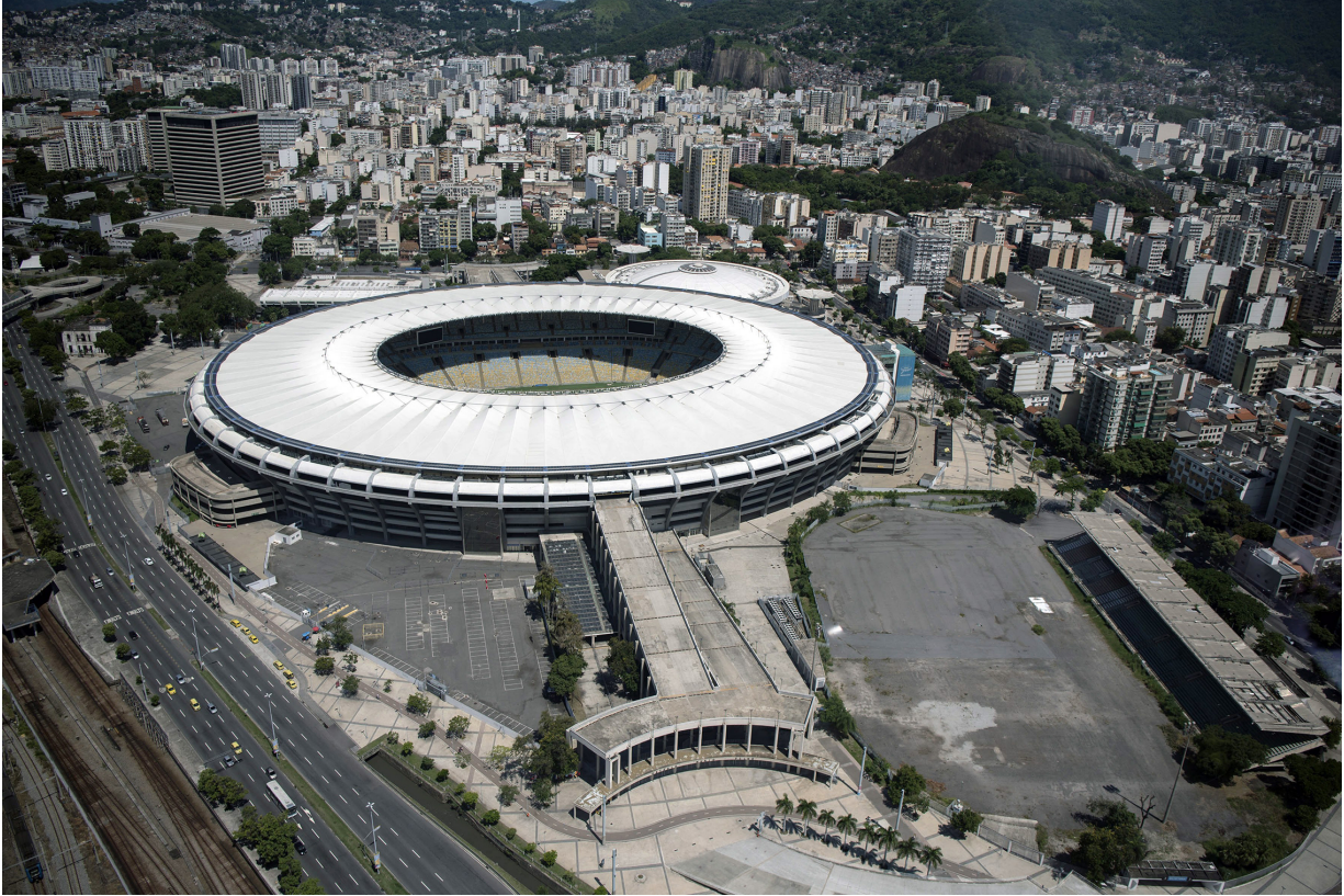
Vista aérea do novo Maracanã, após a derrubada das marquises. FOTO: RICARDO BELIEL
