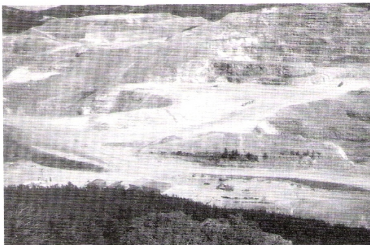
Foto 4. A mina abandonada Zortman-Landusky, em Montana, a primeira nos EUA a experimentar a extração de ouro de minério com baixo teor, em larga escala, através de lixiviação em pilha com cianeto.
