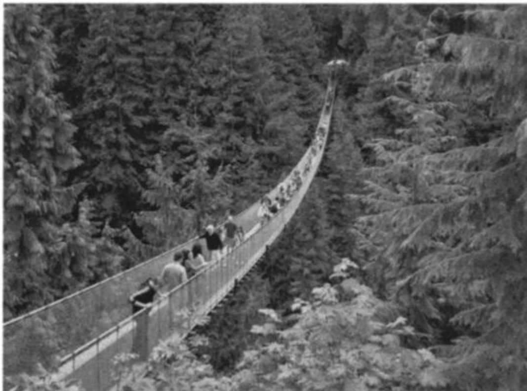
Ponte Suspensa Capilano, North Vancouver, British Columbia. [Créditos: Cortesia de Lisa e Par Shin]
