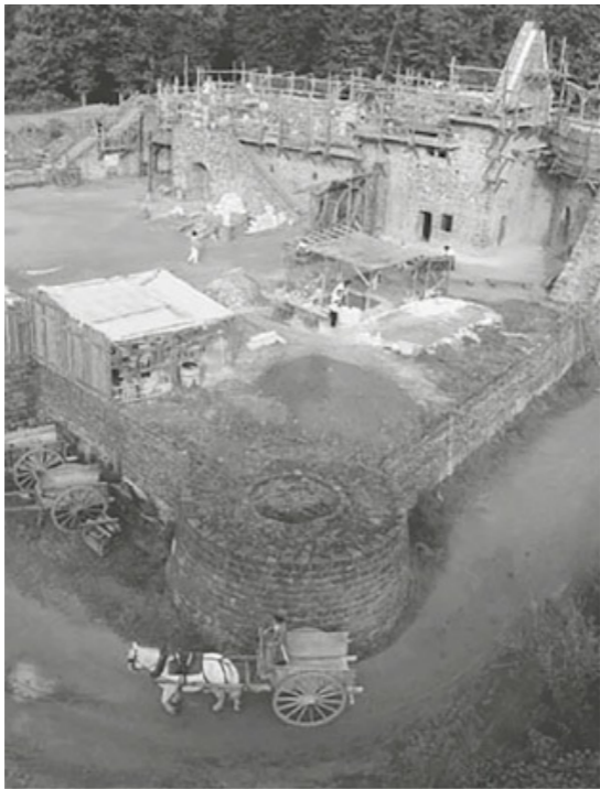
O Castelo de Guédelon em progresso, no final da temporada de trabalho, em 2008.
