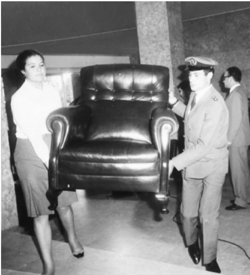
A 7 de setembro de 1968, Salazar é operado de urgência na Cruz Vermelha, em Lisboa, após um acidente doméstico no Estoril. Uma das
