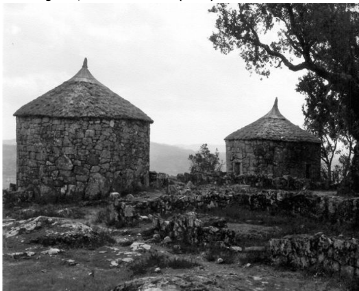
Exemplos (reconstrução) de edificações típicas dos castros: casas circulares, feitas de pedra.
