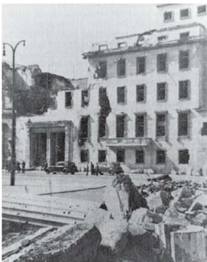
67. Ruínas do edifício da velha Chancelaria do Reich no final de maio de 1945. A famosa sacada de onde Hitler saudou a multidão de partidários devotos e viu tantas demonstrações entusiásticas, continuava na fachada do edifício destruído.
