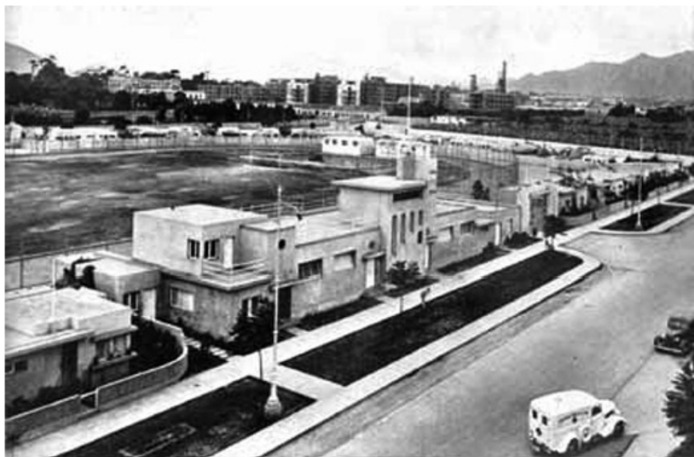
Figura 2 – 1º Barrio Obrero em Lima, projetado pelo arquiteto Alfredo Dammert.
