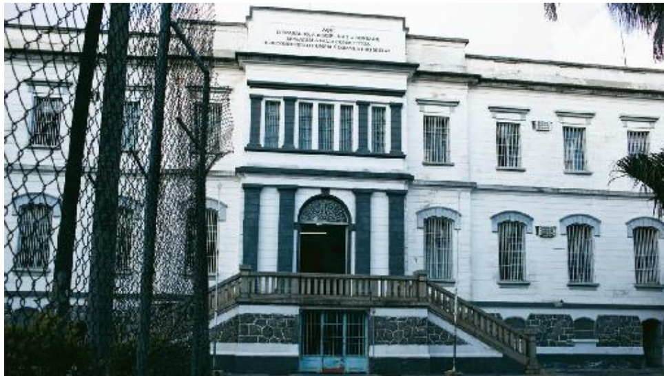
Entrada da Penitenciaría Feminina da Capital. A porta de cima leva ao setor administrativo; o portão azul, abaixo da escadaria, dá acesso às galerias.
