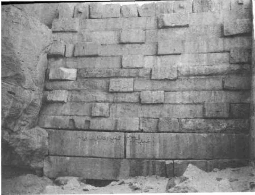
O muro do açude tem 4,62 m de largura. Os monólitos inferiores têm 3,54 m de comprimento e 51 ande largura.
