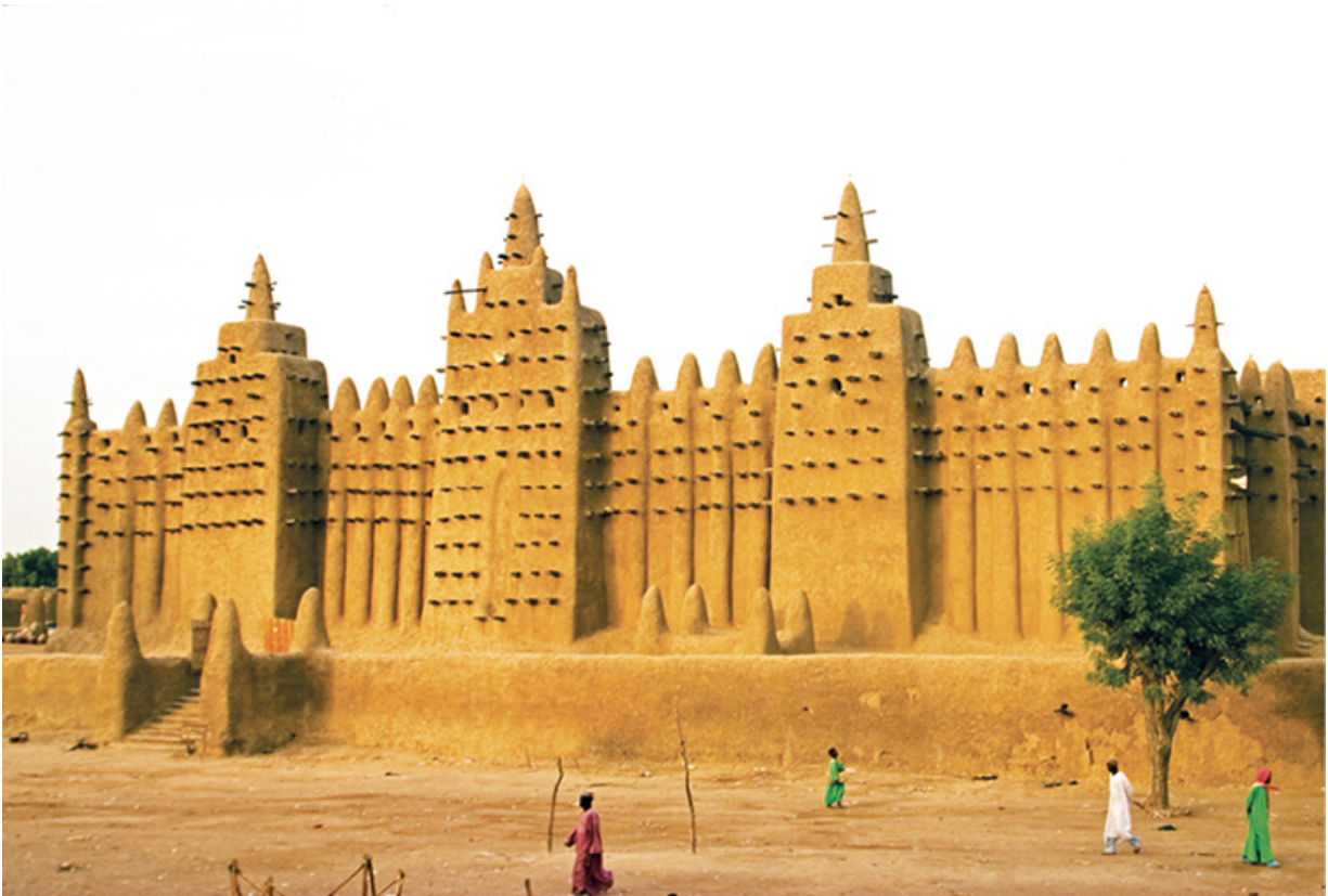
12. A Grande Mesquita em Djenné-Jeno é o maior edifício de tijolos de barro do mundo. A primeira mesquita a ser construída no local é do século XIII. A estrutura atual data de 1907.
