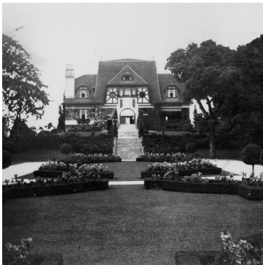
Sede da propriedade em Brocoió, na ilha particular de Octávio Guinle
