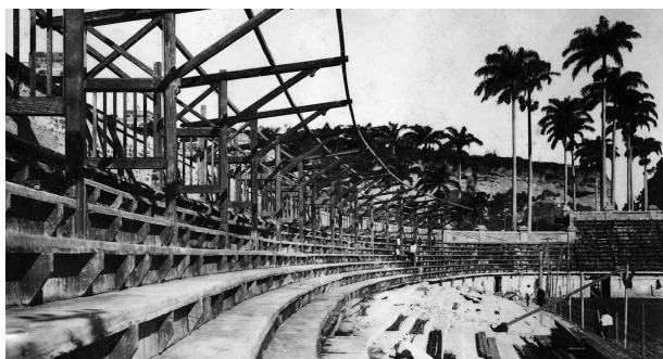
Campo do Fluminense em construção.
