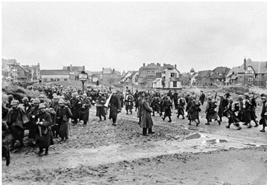
2. Coluna de soldados da infantaria belga na praia de De Panne: “Ele se encontra nas trincheiras localizadas em uma faixa do território belga que não foi ocupada. Essa faixa vai de Nieuwpoort, perto do canal da Mancha, até Ypres e Messines, na fronteira francesa”.
