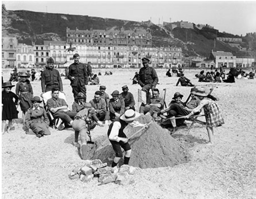
8. Cena litorânea em Boulogne-sur-Mer: “À tarde, Cushing retorna para a espaçosa casa de praia onde vive agora. Através das janelas abertas, sente o ar quente e vislumbra o canal da Mancha”.
