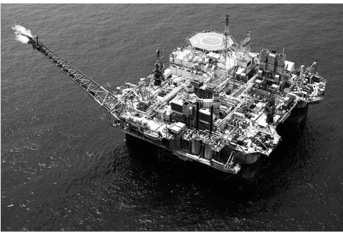
34. A plataforma da Petrobras operando sobre uma camada de água de 780m no campo de Marlin, na costa brasileira, ultrapassou a fronteira das águas profundas em 1992. Hoje a produção *offshore* responde por 30% da oferta global de petróleo.
